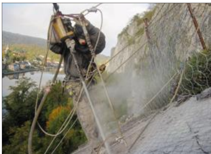
Wilfried Jacquel lors de la pose de filets pare-éboulis à Charleroi en Belgique, en surplombant la Meuse. Photo DR
