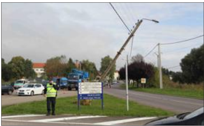
Le poteau qui penchait dangereusement est en cours de remplacement. Photo RL
